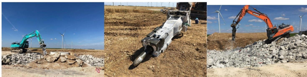
Figure 10 : Photographies issues d'une visite de chantier de démantèlement en France (SOURCE : H2AIR)
